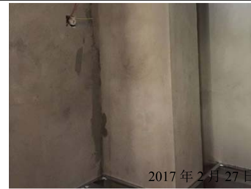
住宅楼内置排烟管道
